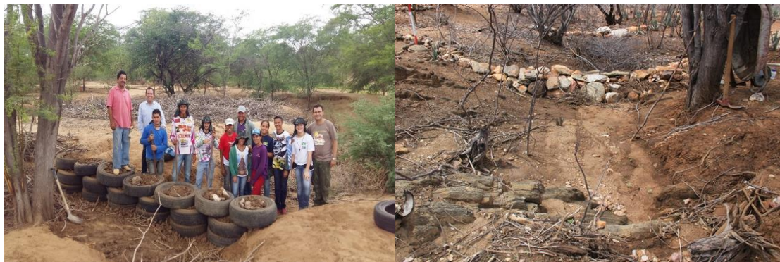
Figura 6. Contenção dos processos de erosão mais acentuados utilizando cordões de pedras e pneus em arco.
