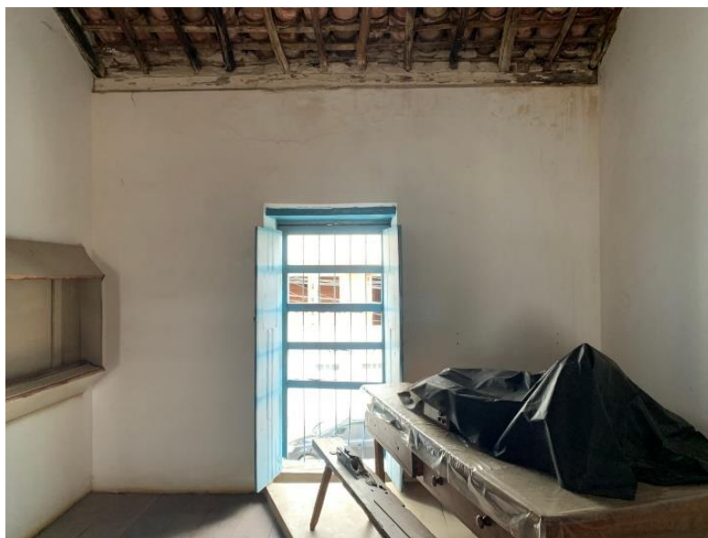
Figura 30 – Parede 7, Sala 4 no Pavimento Superior
