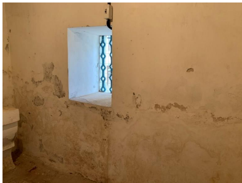
Figura 23 – Parede 1, Sala 2 no Pavimento Térreo
