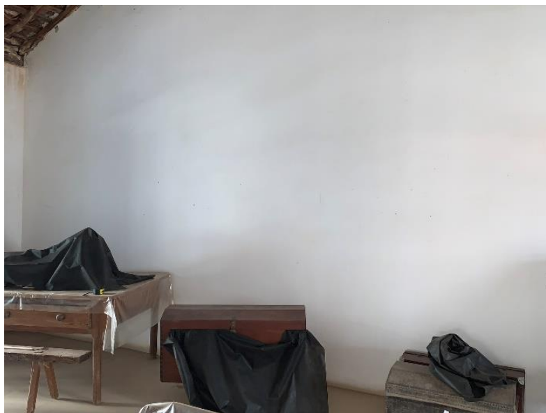
Figura 33 – Parede 10, Sala 4 no Pavimento Superior
