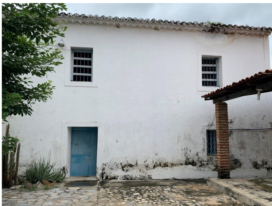
Figura 3 – Fachada Noroeste do Museu do Seridó atual
