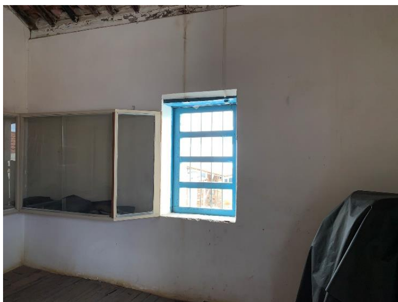
Figura 36 – Parede 9, Sala 5 no Pavimento Superior
