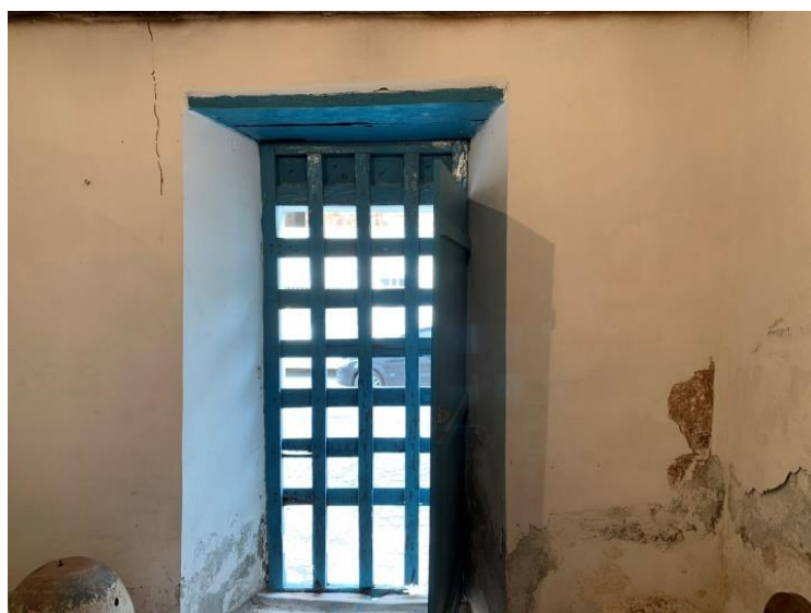
Figura 27 – Parede 3, Sala 3 no Pavimento Térreo
