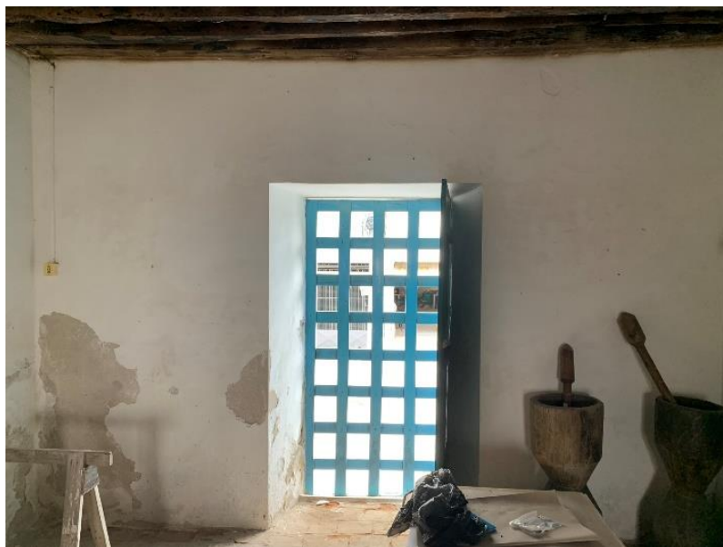
Figura 20 – Parede 3, Sala 1 no Pavimento Térreo
