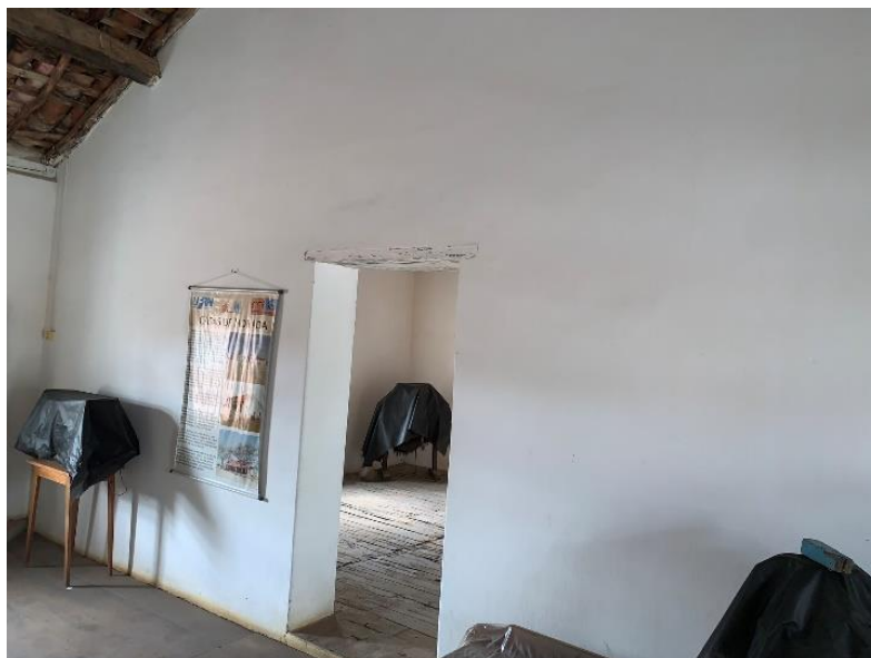
Figura 31 – Parede 11, Sala 4 no Pavimento Superior
