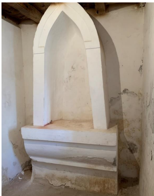
Figura 24 – Parede 4, Sala 2 no Pavimento Térreo
