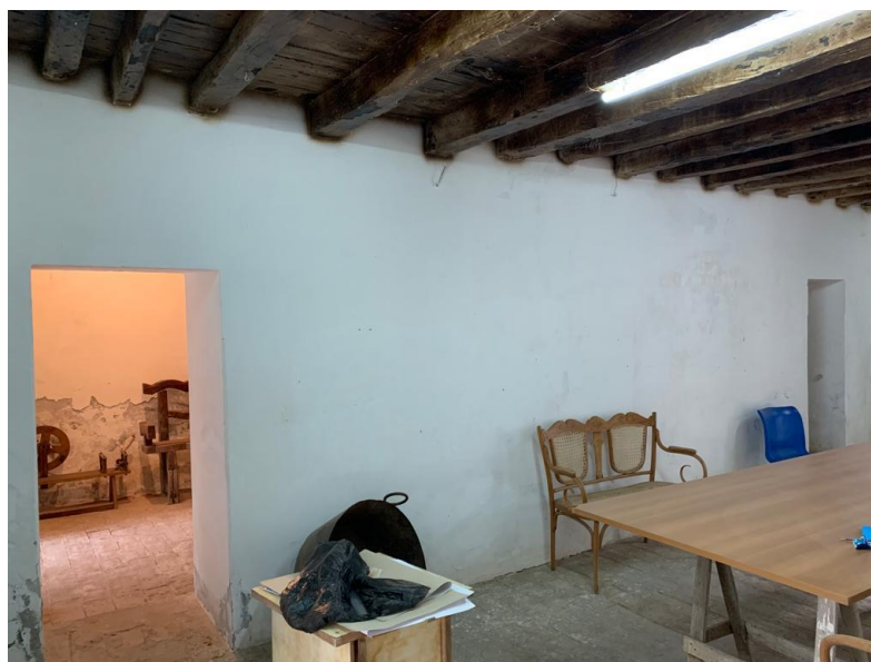
Figura 21 – Parede 5, Sala 1 no Pavimento Térreo
