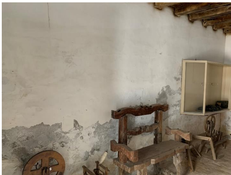
Figura 28 – Parede 4, Sala 3 no Pavimento Térreo
