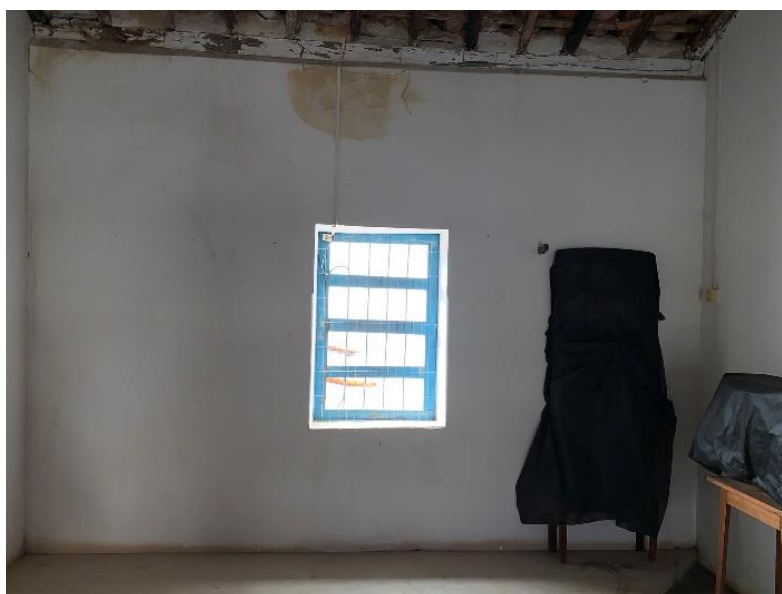
Figura 32 – Parede 9, Sala 4 no Pavimento Superior
