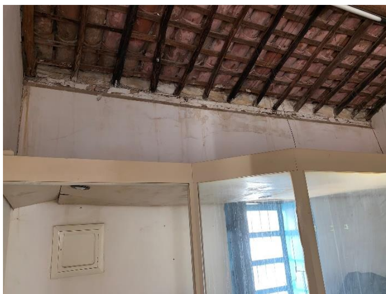
Figura 34 – Parede 7, Sala 5 no Pavimento Superior
