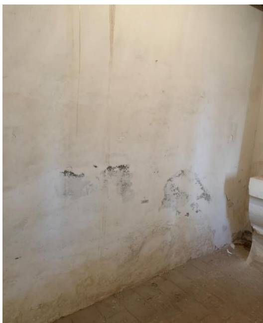
Figura 25 – Parede 6, Sala 2 no Pavimento Térreo
