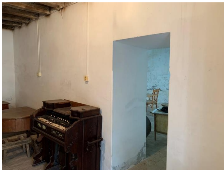
Figura 26 – Parede 5, Sala 3 no Pavimento Térreo
