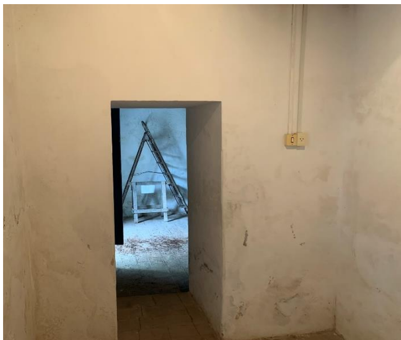
Figura 22 – Parede 5, Sala 2 no Pavimento Térreo
