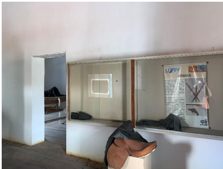
Figura 37 – Parede 11, Sala 5 no Pavimento Superior
