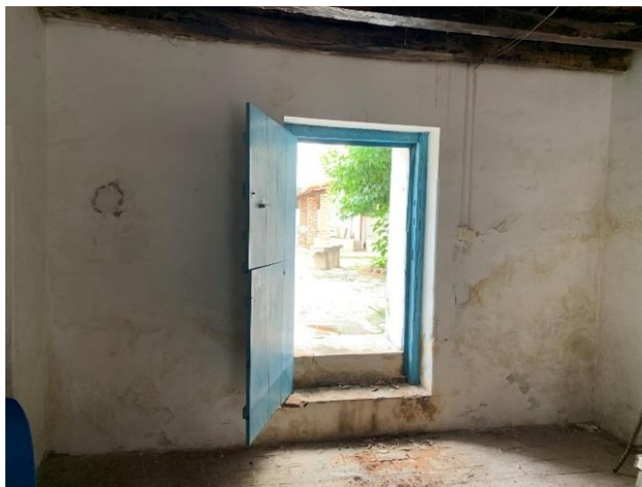
Figura 18 – Parede 1, Sala 1 no Pavimento Térreo
