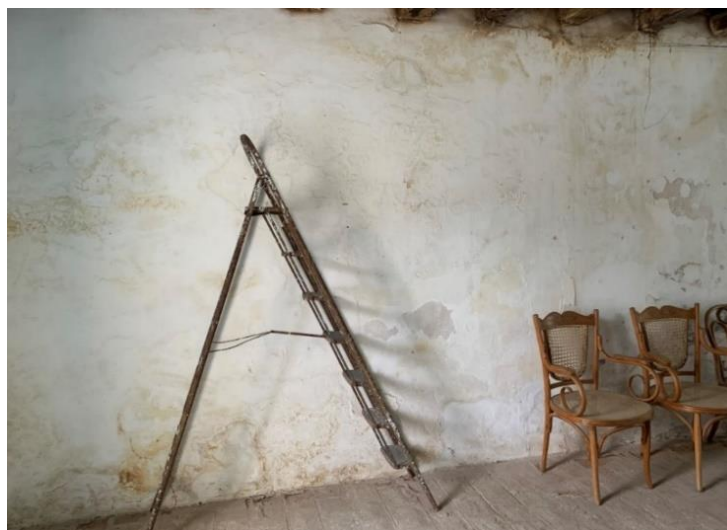
Figura 19 – Parede 2, Sala 1 no Pavimento Térreo
