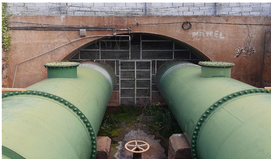
Figura 23: Túnel e Canal de adução
