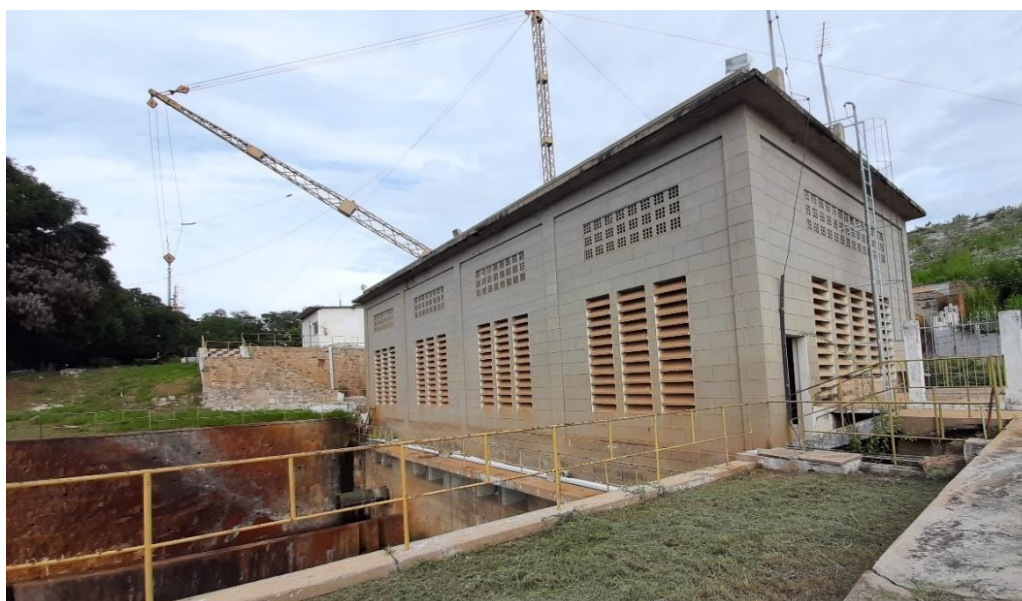
Figura 27: Casa de máquinas
