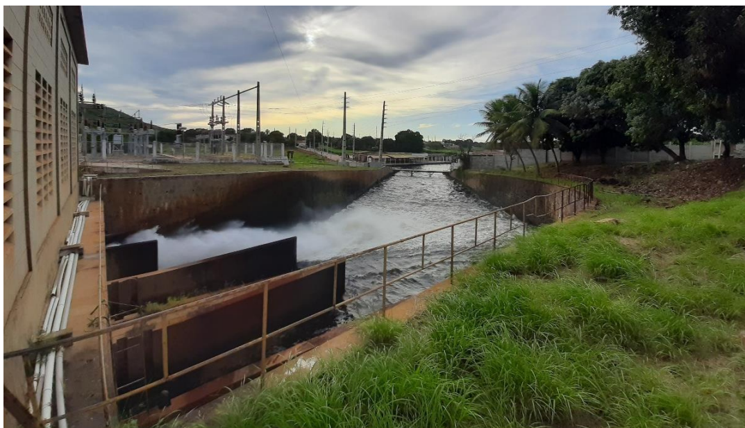
Figura 29: Canal de Fuga
