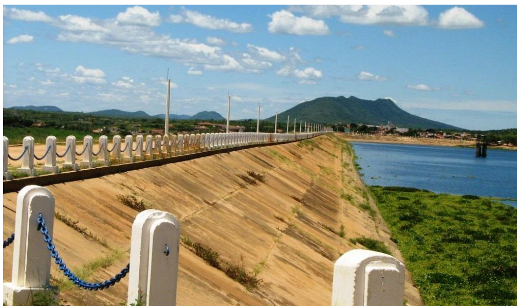
Figura 20: Vista à montante da barragem
