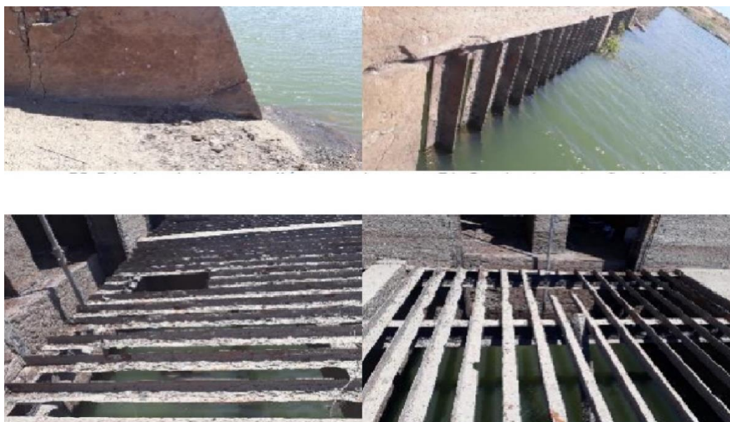
Figura 22: Entrada e grades de segurança da tomada d'água
