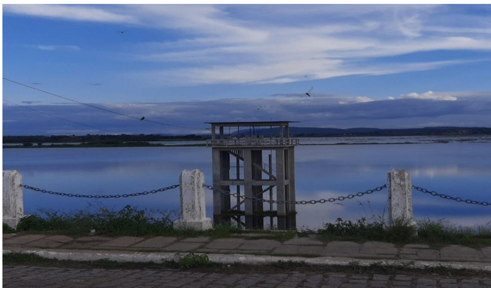
Figura 21: Vista da torre de tomada d'água
