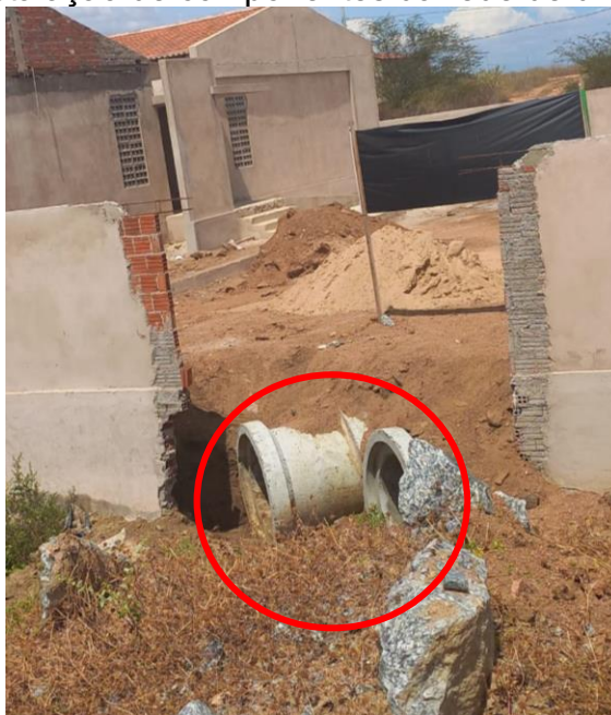
Figura 29 - Instalação de componentes da rede de drenagem.
