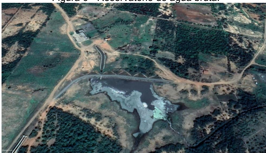
Figura 6 - Reservatório de água bruta.
