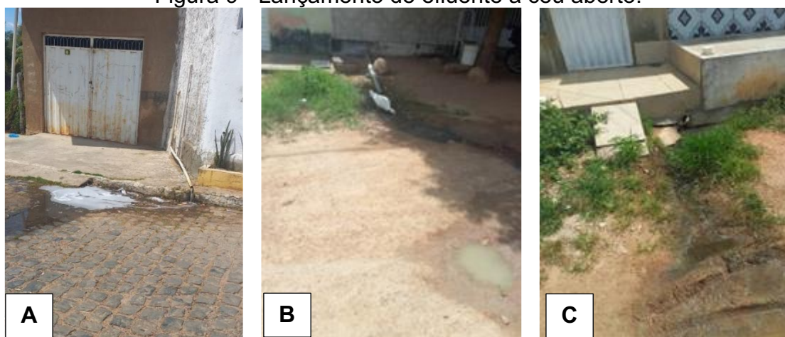
Figura 9 - Lançamento de efluente a céu aberto.
