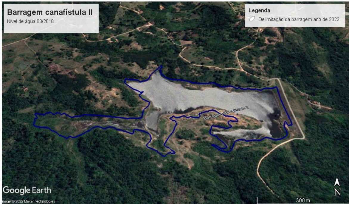
Figura 10 – Nível de água da Barragem Canafístula II – 2018.
