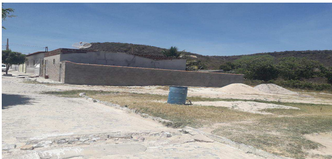
Foto 10 - Rachadura nas casas em São José da Batalha.
