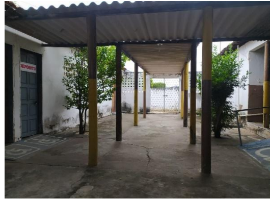
Figura 10 - Entrada de acesso
