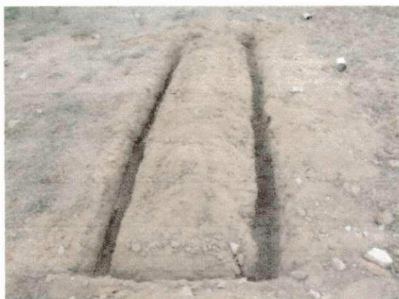
Figura 15 - Valeta para implantação do barramento de água
