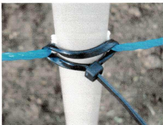
Figura 22 - Fixação do cabo nos arcos
