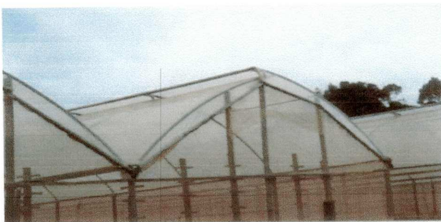
Figura 2 - Casa de vegetação com teto convectivo
