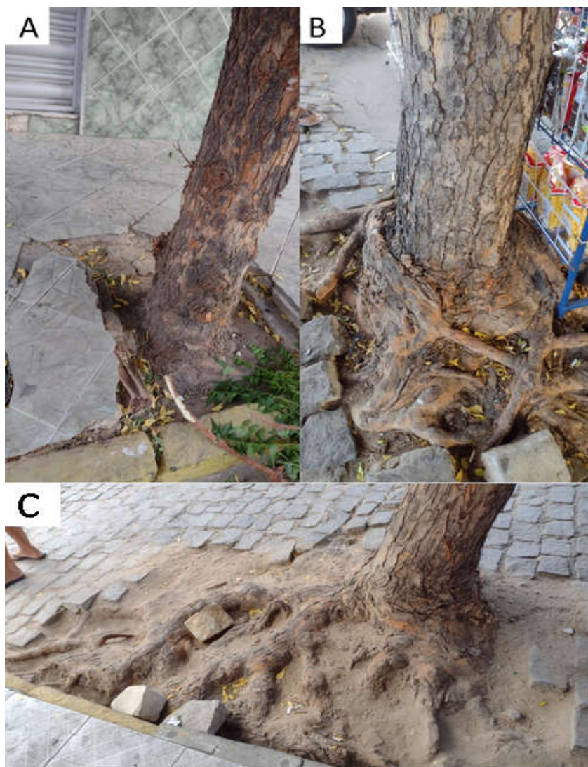
Figura 5:Exposição das raízes danificando calçadas (A e B) e o calçamento (C).
