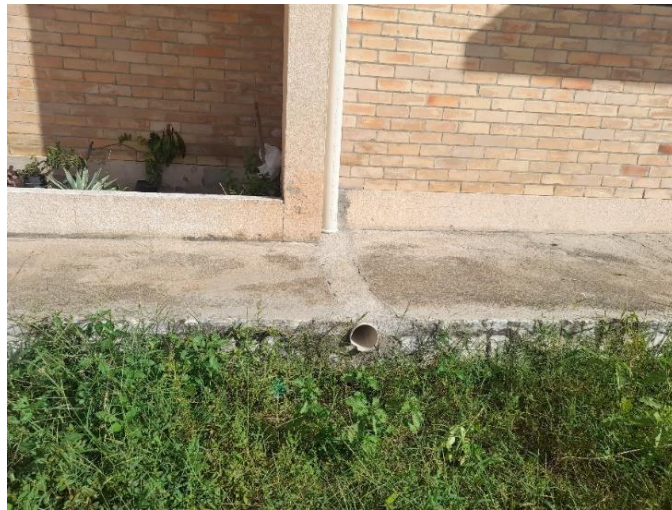
Figura 12 – Condutor vertical e horizontal da residência universitária masculina, campus Pombal-PB
