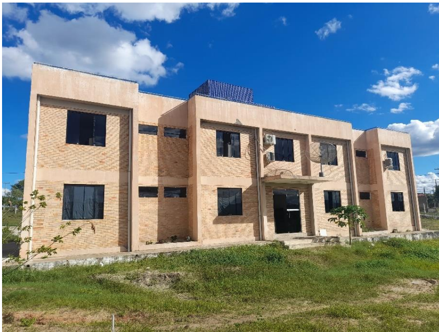
Figura 10 – Fachada da residência universitária masculina da UFCG campus Pombal-PB
