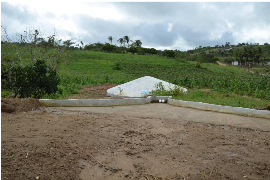
Figura 1 – Cisterna de enxurrada
