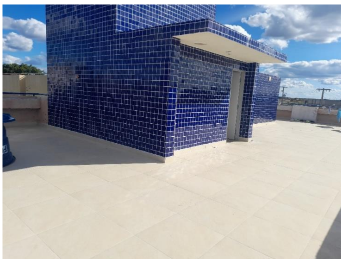
Figura 11 – Cobertura da residência universitária masculina, UFCG campus Pombal-PB
