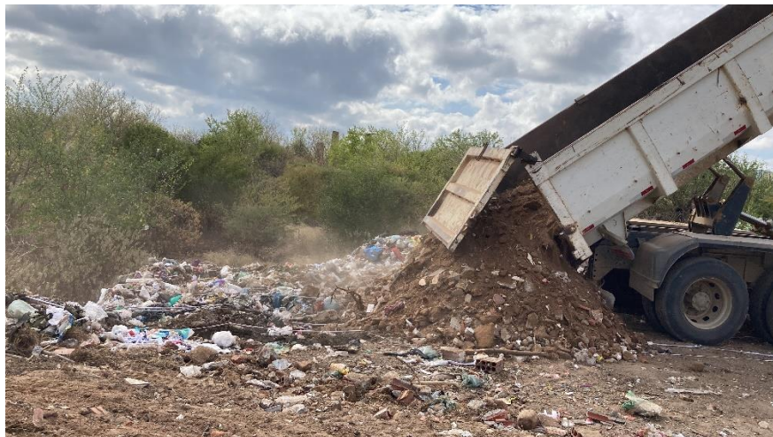
Figura 16 - Caminhão Caçamba aterrando os resíduos.
