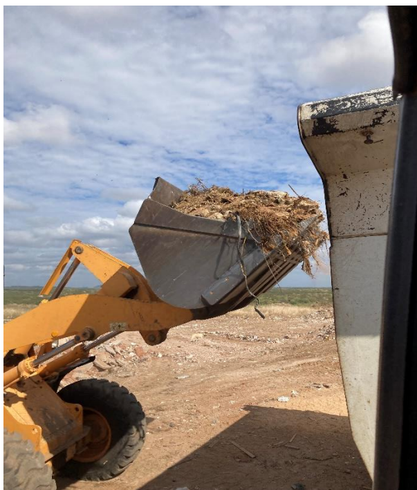
Figura 15 - Retroescavadeira recolhendo os resíduos.
