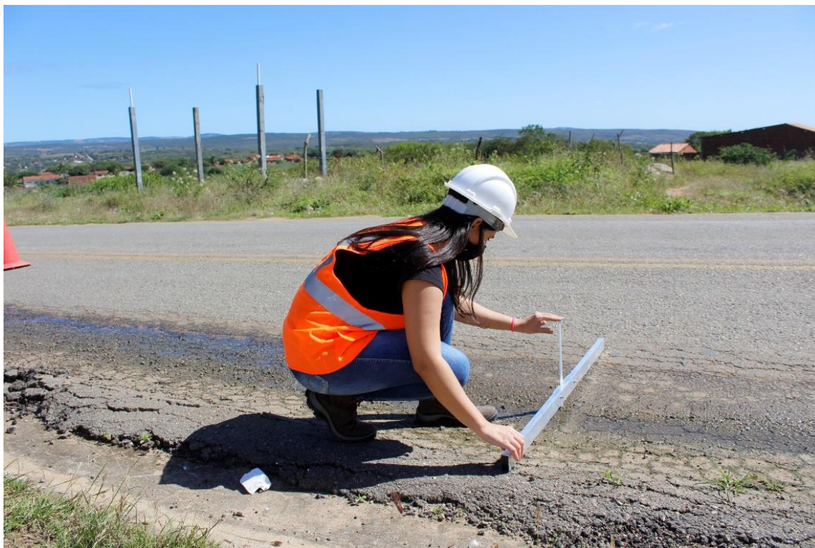
Figura 20 – Medição de Afundamento de Trilha de Roda Externa na PB-306.
