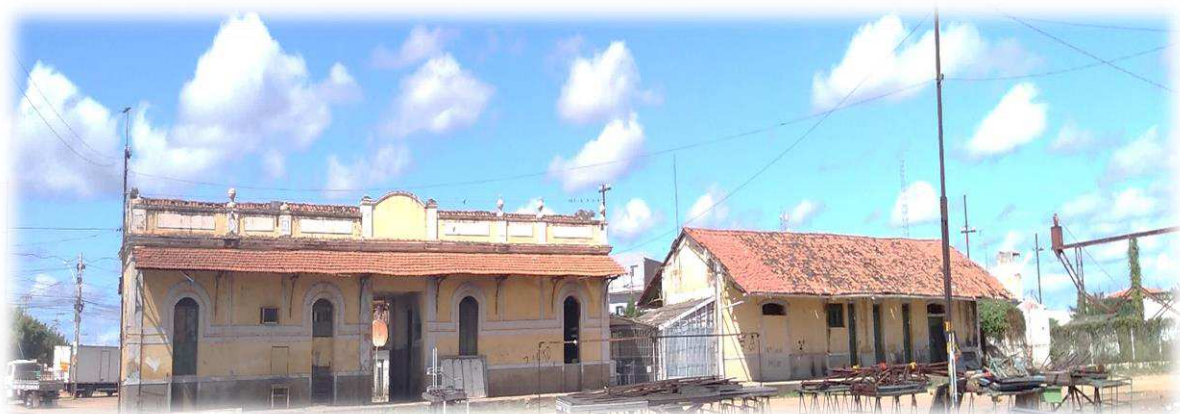
Imagem 19: Estação ferroviária de Sousa
