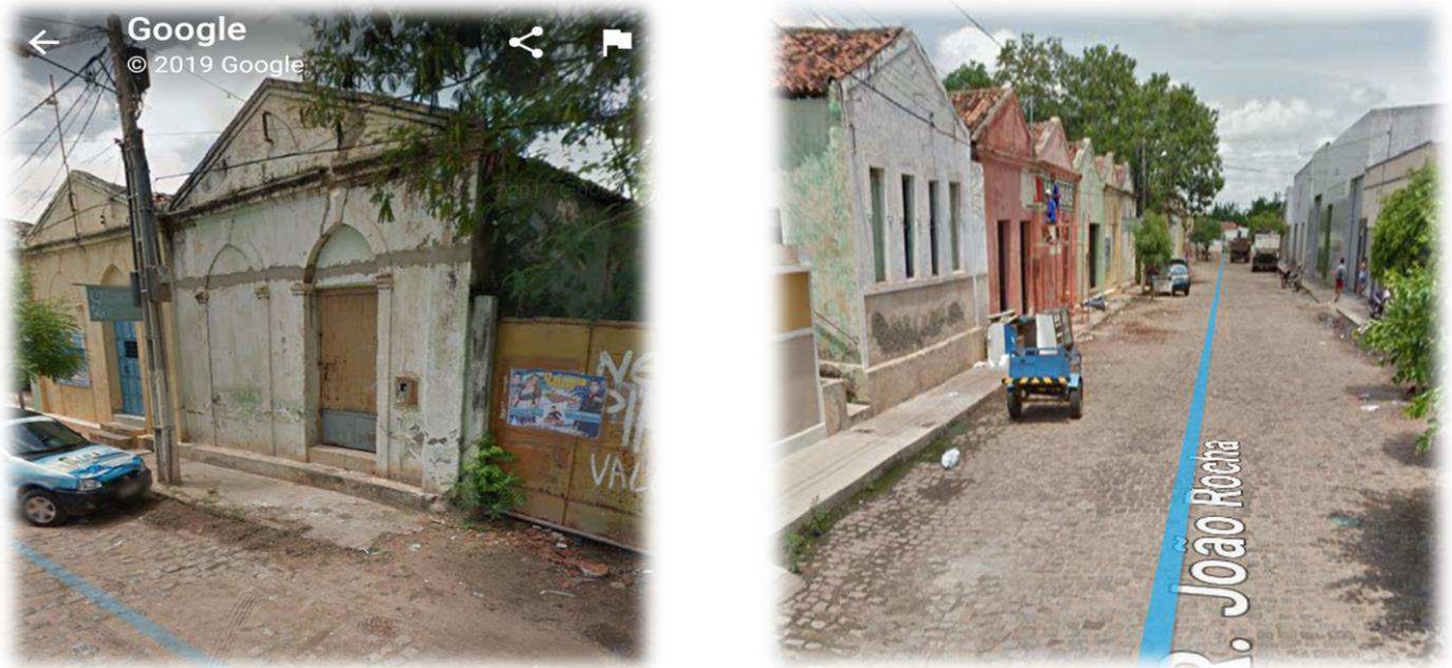
Imagem 15: Resquícios da fábrica Santa Tereza no Alto Capanema em Sousa-PB
