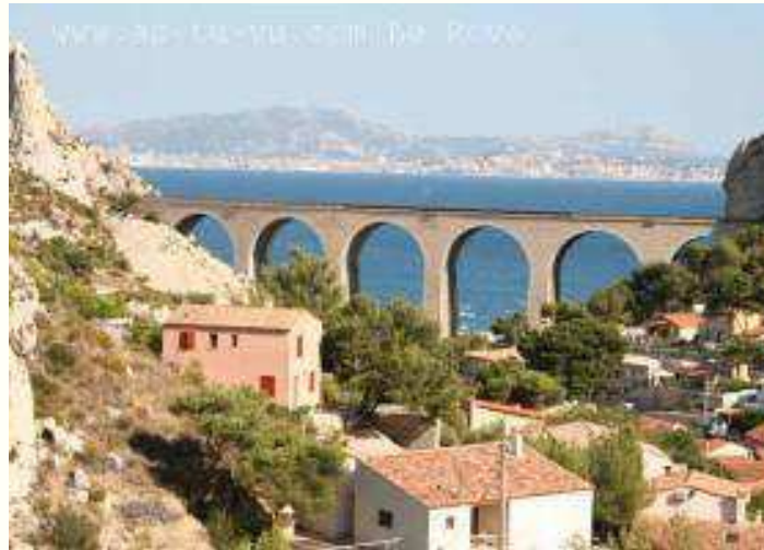
Figura 24: Viaduto de L'Estaque, França. Fonte:< http://www.mairie-ensues.fr/estaque.html >
