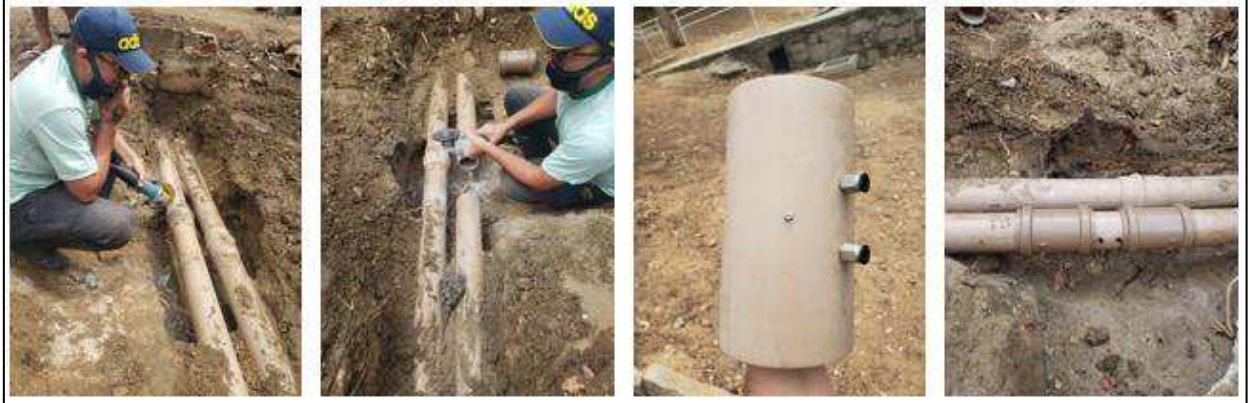
Figura 20 - Instalação do protótipo macromedidor na rede de distribuição estudada
