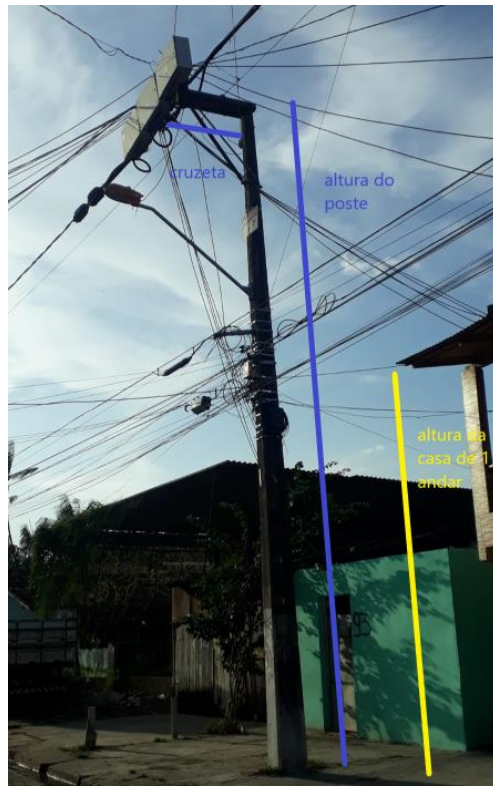
Figura 17: Estrutura de poste e cruzeta.
