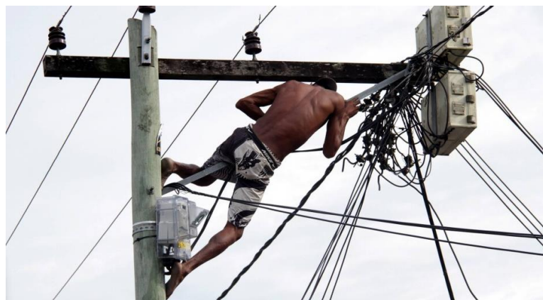
Figura 18: Tentativa de ligação clandestina na rede de distribuição.
