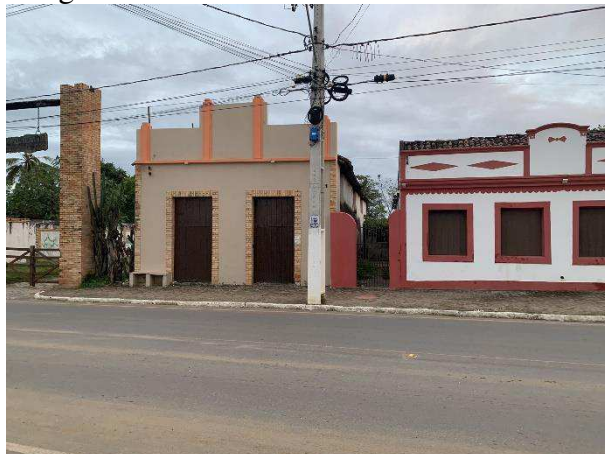
Figura 17 – Início dos casarios reformados
