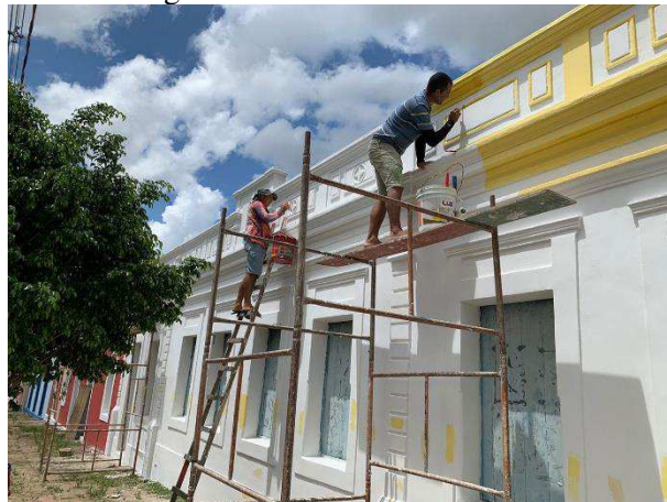
Figura 15 – Pintura das fachadas
