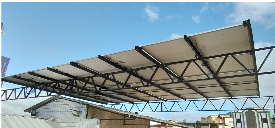
Figura 26 – Estrutura projetada para instalação de módulos fotovoltaicos.
