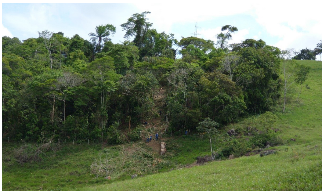
Figura 20: Abertura de faixa de servidão entre estruturas 7/1 e 6/3.
