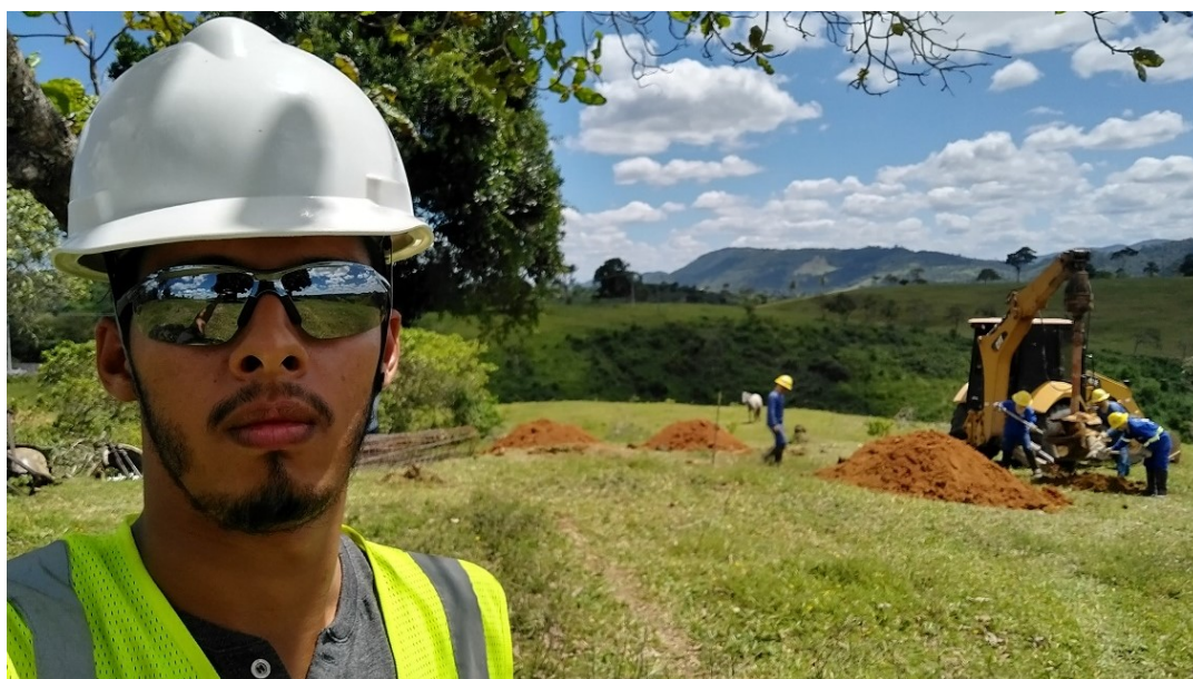
Figura 11: Inspeção equipe de escavação estrutura 1/2.
