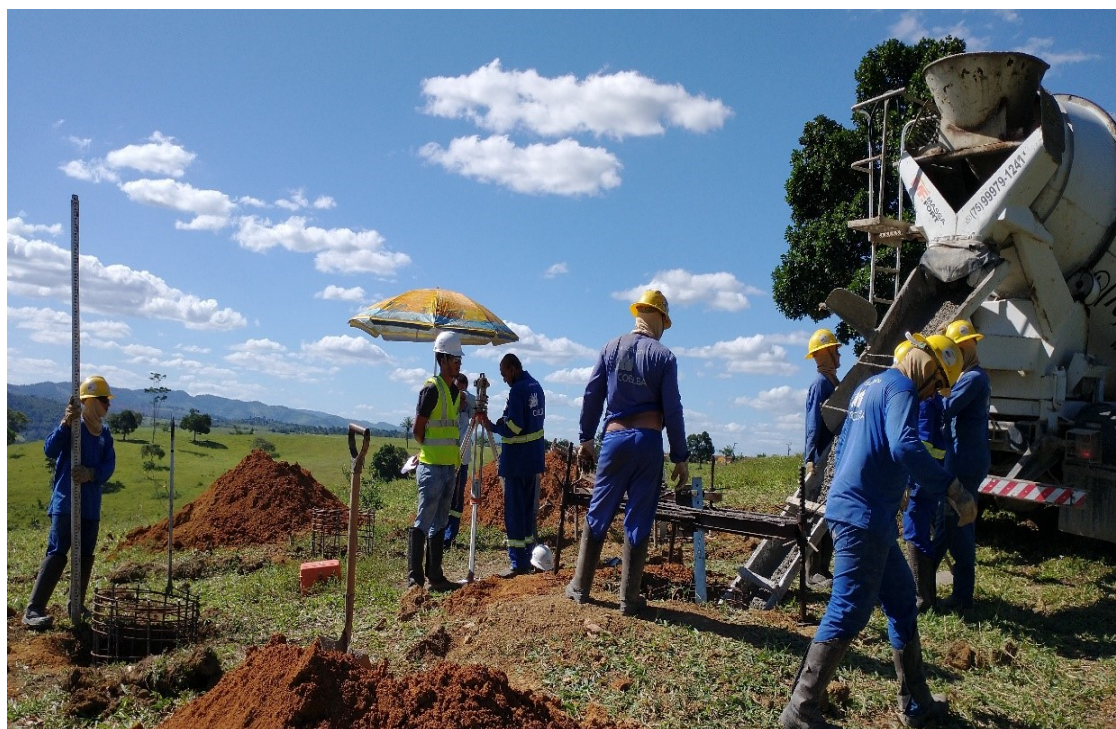
Figura 12: Concretagem estrutura 1/2.
