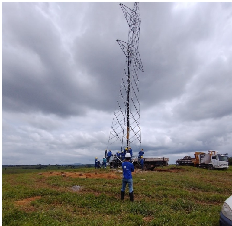
Figura 15: Içamento estrutura 1/1.
