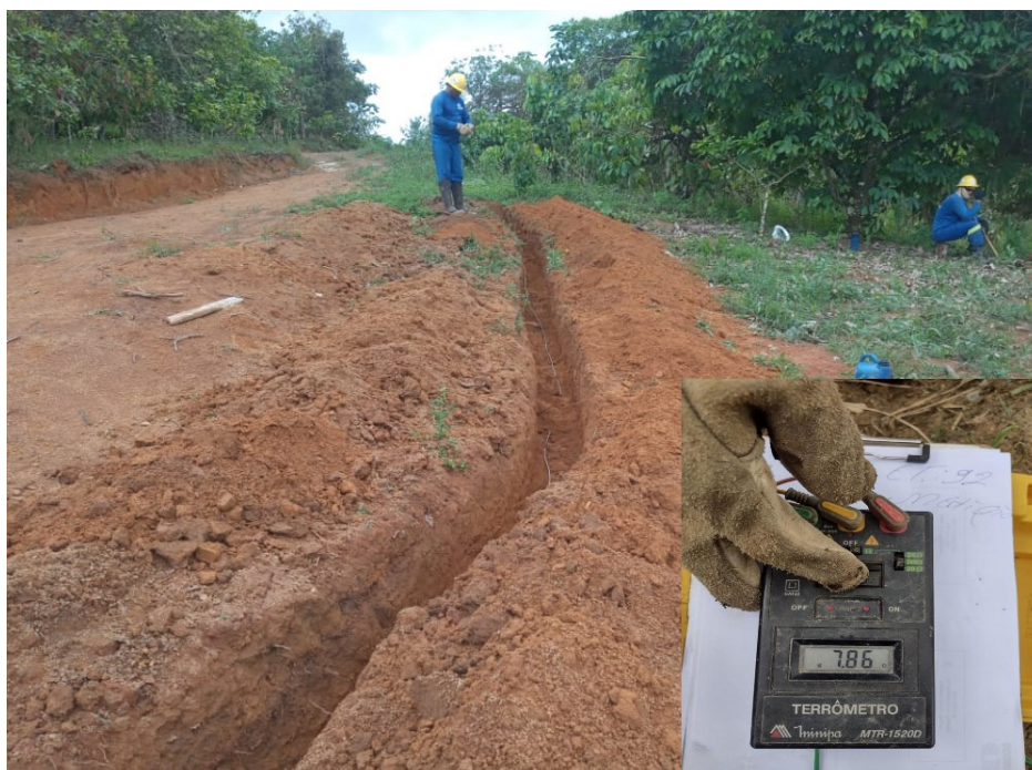
Figura 17: Construção da malha de aterramento e medição de resistência estrutura 30/2.
