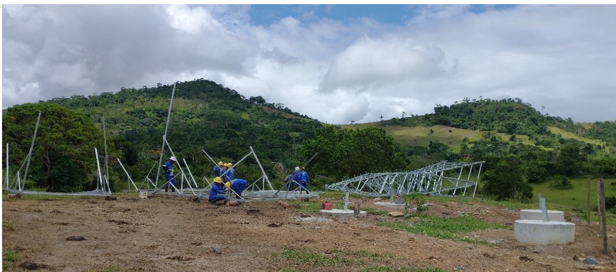
Figura 14: Pré-montagem estrutura 3/2.
