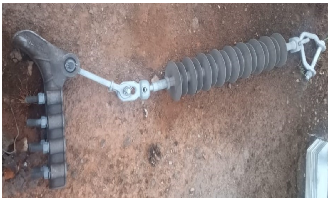
Figura 19: Montagem modelo, cadeia de isolador estrutura ancoragem.
