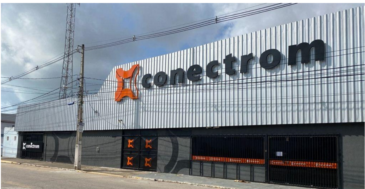
Figura 2: Fachada da Conectrom Engenharia e Telecomunicações.
