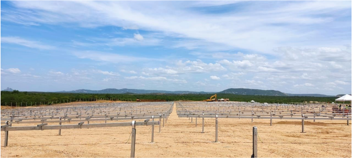
Figura 23: Instalação dos trackers .
