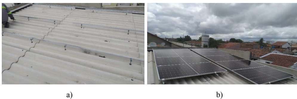
Figura 14 - Instalação dos painéis fotovoltaicos.
