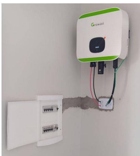
Figura 15 - Instalação do inversor.
