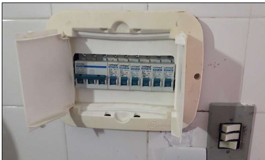
Figura 12: Após a substituição dos circuitos e disjuntores.
