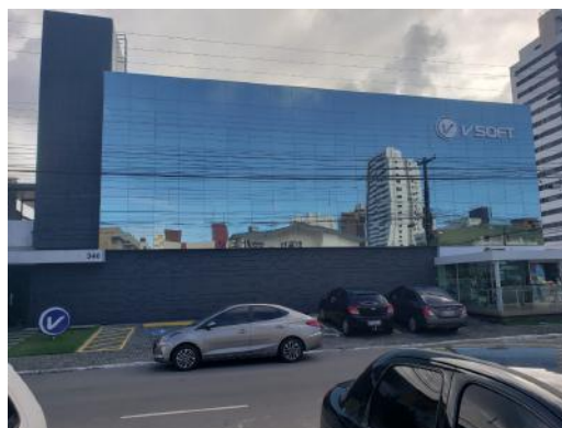
Figura 1 – Sede João Pessoa.
