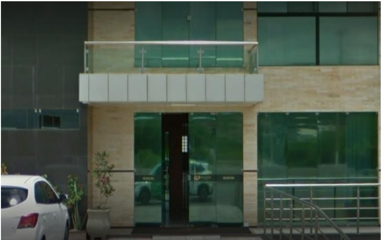
Figura 2 - Fotografia da fachada da Allumer Engenharia e Energia.
