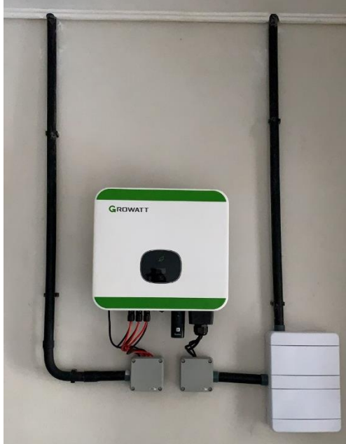
Figura 17 - Instalação do inversor.
