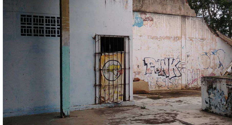
[FIGURA 82] PORTÃO DE AÇO/SAÍDA DE EMERGÊNCIA DO CUCA. FONTE: ACERVO PESSOAL, 2021.
