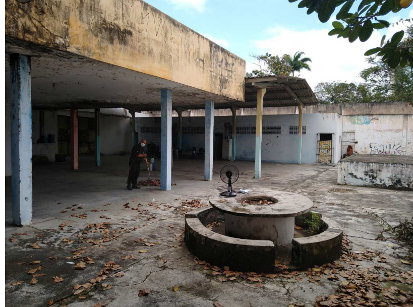
[FIGURA 70] ESTRUTURA EM CONCRETO ARMADO DO CUCA, COM VISTA PARA OS
