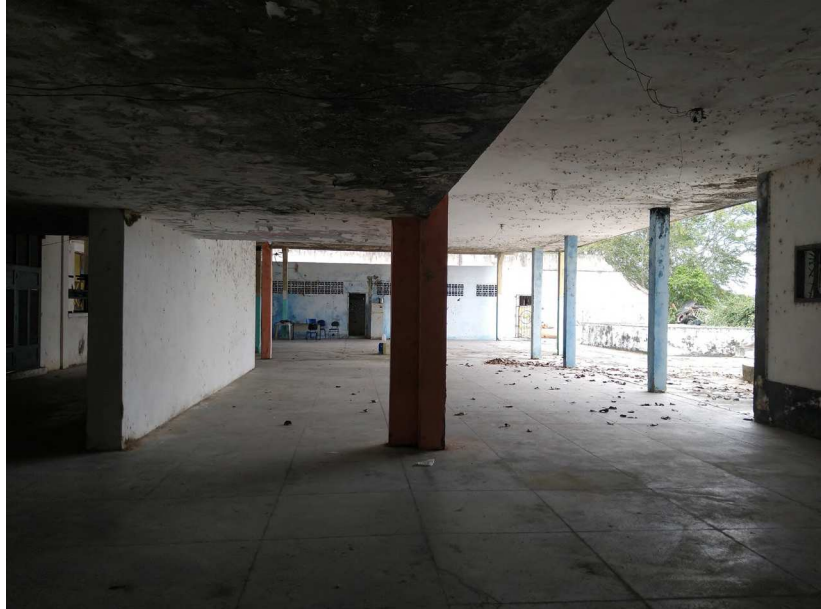
[FIGURA 69] ESTRUTURA EM CONCRETO ARMADO DO CUCA.
