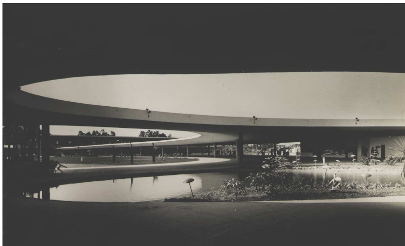
[FIGURA 9] VISTA INTERNA DA MARQUISE DO IBIRAPUERA. FONTE: ACERVO DO MUSEU PAULISTA DA USP | ARCHDAILY.COM.BR
