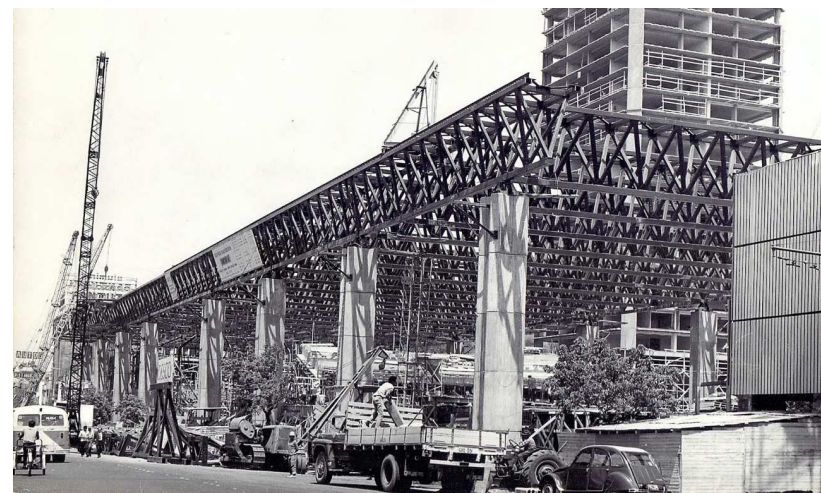
[FIGURA 19] PERSPECTIVA EXTERNA DA EDIFICAÇÃO ORIGINAL EM CONSTRUÇÃO.
