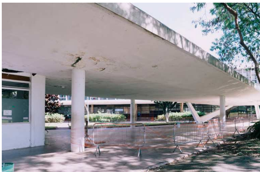
[FIGURA 13] INFILTRAÇÕES PRESENTES NA MARQUISE. FONTE: FOLHA - UOL
