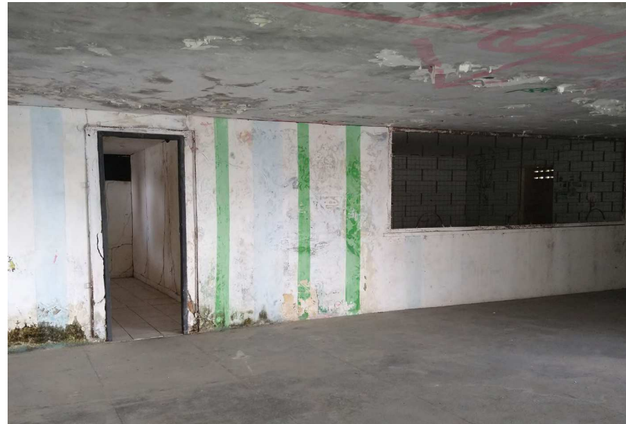
[FIGURA 84] MARCO DAS PORTAS E GRADIL DA CANTINA. FONTE: ACERVO PESSOAL, 2021.
