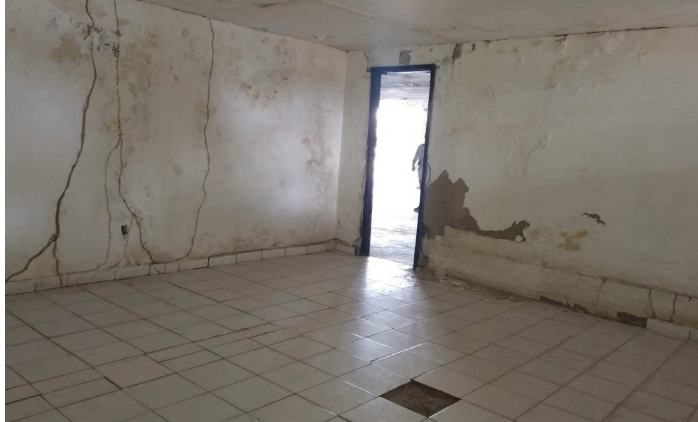
[FIGURA 87] PISO EM CERÂMICA COM RODAPÉ PRESENTES NAS SALAS DO CUCA. FONTE: ACERVO PESSOAL, 2021.
