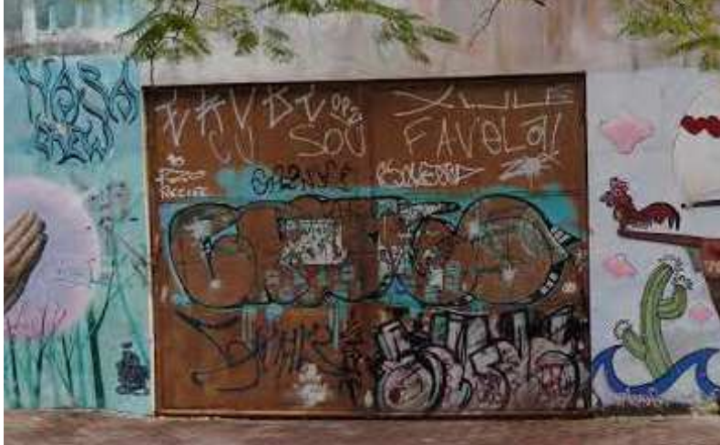
[FIGURA 81] PORTÃO DE AÇO/SAÍDA DE EMERGÊNCIA DO CUCA. FONTE: ACERVO PESSOAL, 2021.
