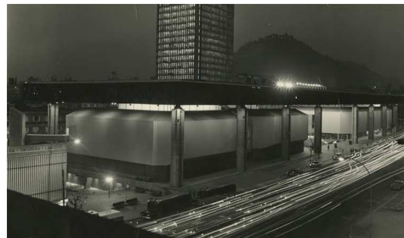
[FIGURA 20] PERSPECTIVA EXTERNA DA EDIFICAÇÃO ORIGINAL.
