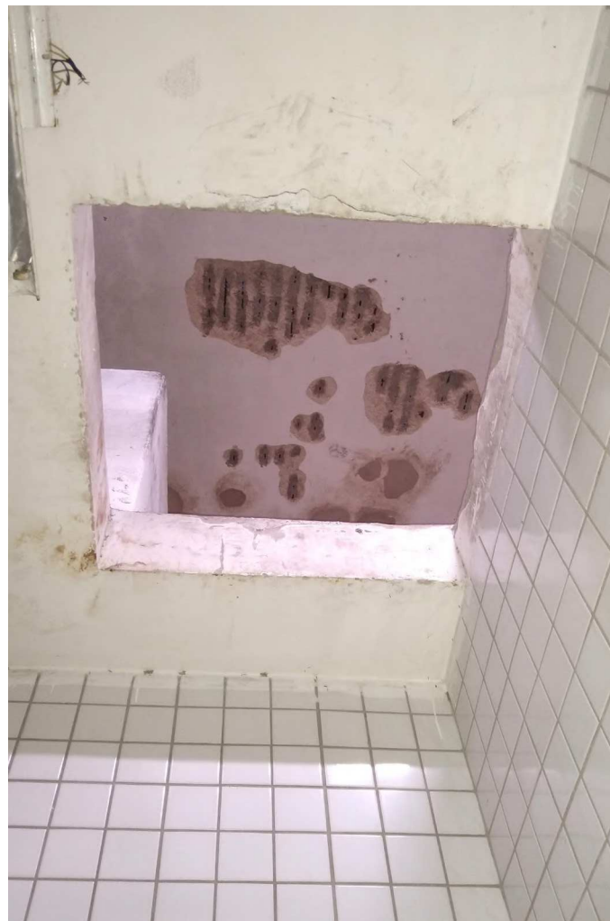
[FIGURA 77] ACESSO À CAIXA D'ÁGUA EM ALVENARIA DO CUCA, OU SÓTÃO, VISTA DO INTERIOR DA COPA. FONTE: ACERVO PESSOAL, 2021.
