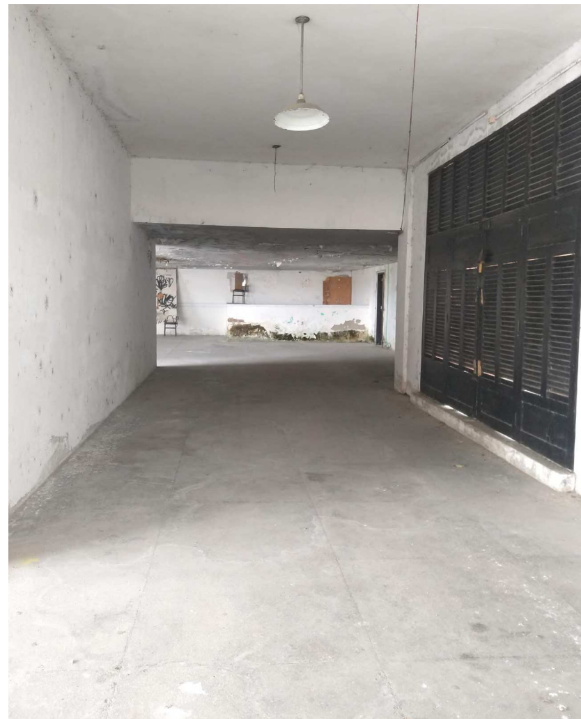
[FIGURA 85] PISO DE CONCRETO PRESENTE NOS AMBIENTES GERAIS DO CUCA. FONTE: ACERVO PESSOAL, 2021.
