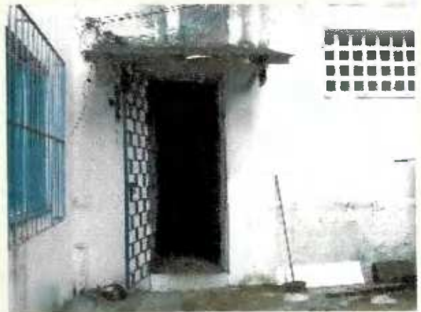
97- Instituto de Preservação e Reforma. Salvador-BA
