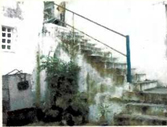
96- Instituto de Preservação e Reforma. Salvador-BA
