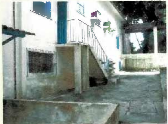
99- Instituto de Preservação e Reforma. Salvador-BA
