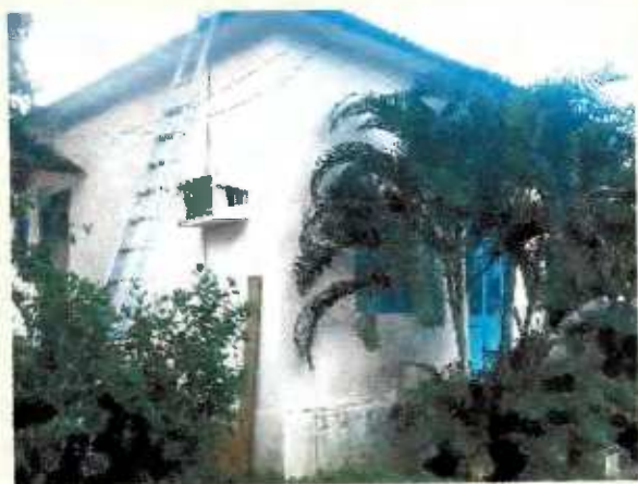
102- Instituto de Preservação e Reforma. Salvador-BA
