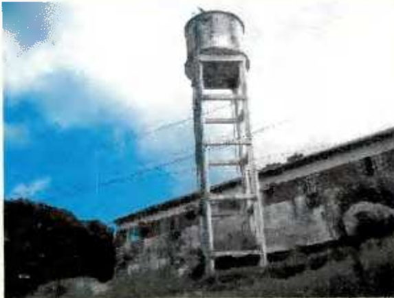
93- Instituto de Preservação e Reforma. Salvador-BA
