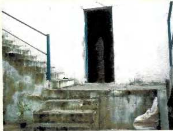
98- Instituto de Preservação e Reforma. Salvador-BA
