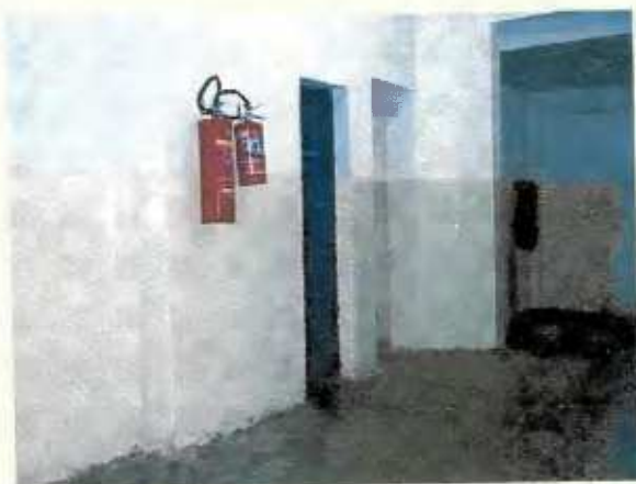
106- Instituto de Preservação e Reforma. Salvador-BA
