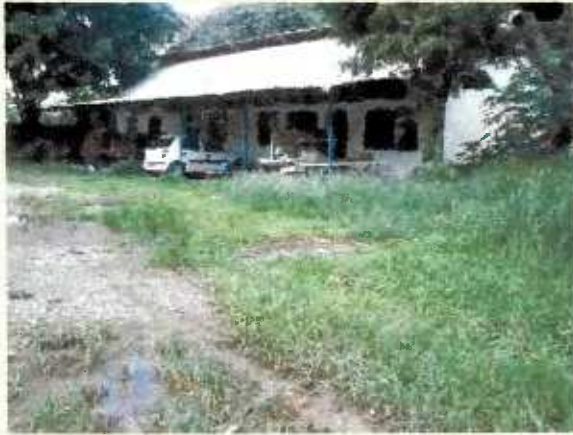
91- Instituto de Preservação e Reforma. Salvador-BA
