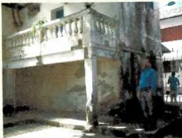
100- Instituto de Preservação e Reforma. Salvador-BA
