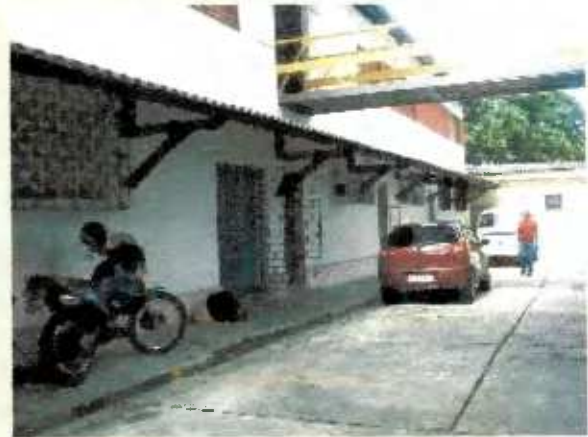
94- Salas de Oficinas Instituto de Preservação e Reforma. Salvador-BA
