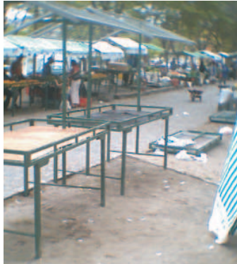
Barracas sendo desmontadas.
