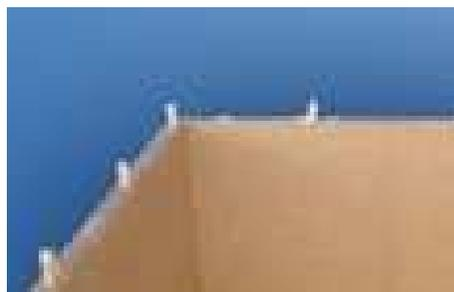
A cavilha de madeira é aplicada por toda a estrutura e é responsável em guiar o encaixe das peças, ela é aplicada em todas as peças da chapa fixa e dos módulos, exeto na porta.
