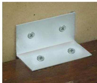
As cantoneira L reforçadas são aplicadas em toda a estrutura na parte posterior do painel com 4 parafusos 3,5 x 12 cabeça chata de 6mm, é essa ferragem a responsável em reforçar a união de todas as peças da chapa fixa do painel de TV para sala de estar.
