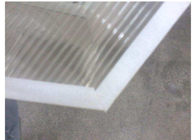
Figura 67 - Detalhe do velcro na cobertura
