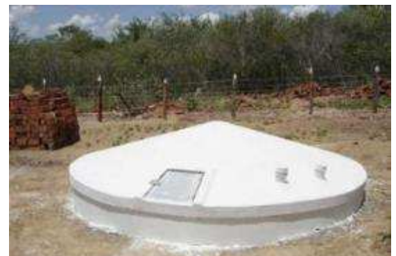
Cisterna de alvenaria
