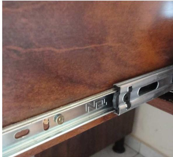
Figura 23: detalhe da corredeira de metal numa gaveta. presa à madeira por parafusamento.
