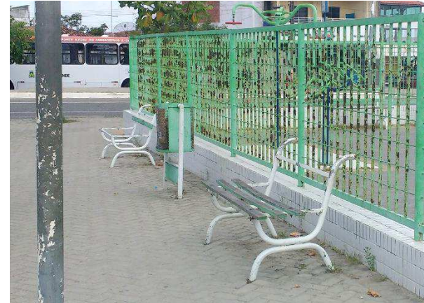
Figura 33: Bancos com encosto quebrados.
