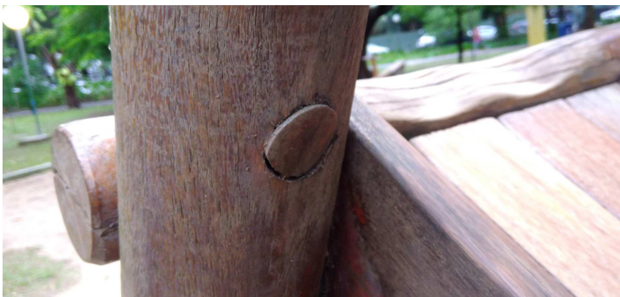
Figura 28: Detalhe de acabamento de união mecânica
