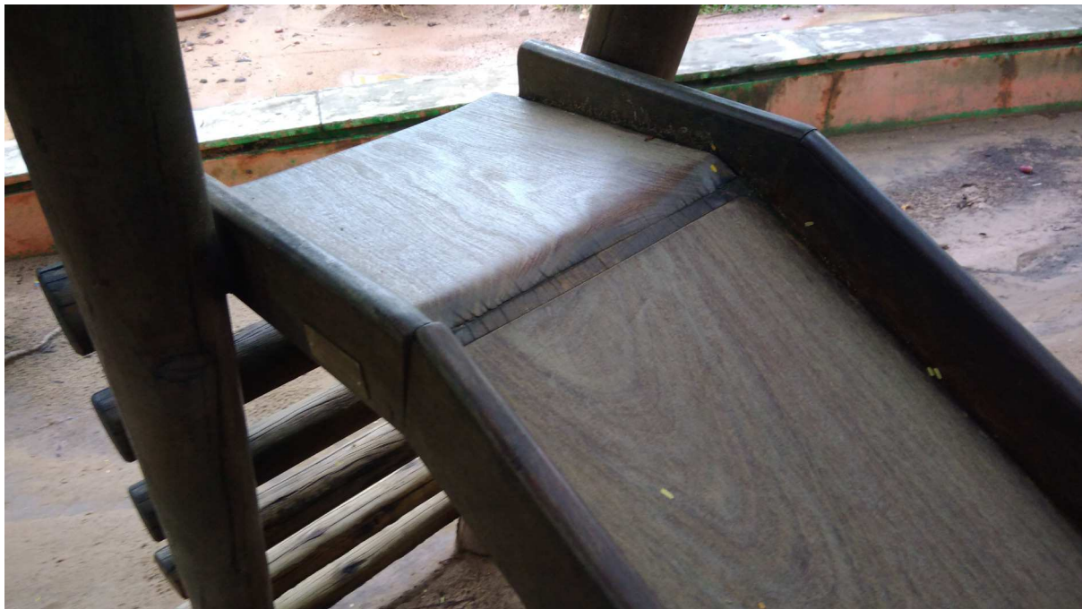
Figura 29: Detalhe da união entre peças do escorrego
