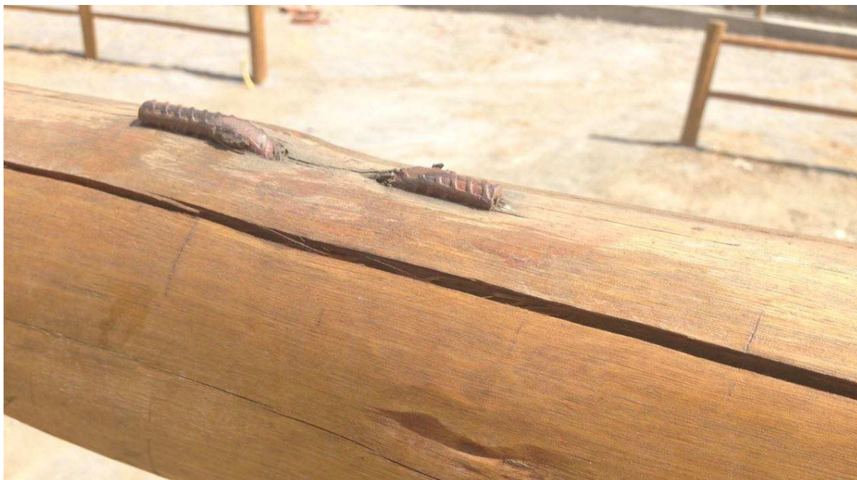
Figura 39: União mecânica entre madeira e corrente, detalhe 1
