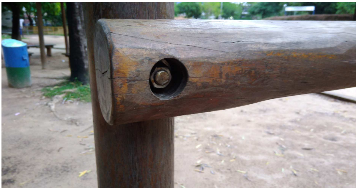
Figura 27: Detalhe da união mecânica por parafuso passante
