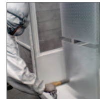
▲ Figura 75: Processo de pintura eletrostática. Fonte: Cotanet, 2018.
