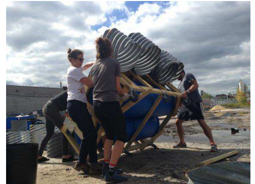
Figura 21: Equipe erguendo a estrutura ainda vazia.
