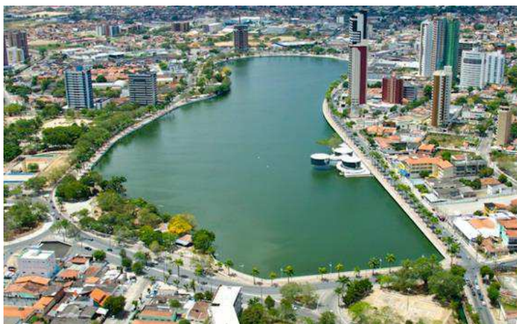
Figura 3: Vista aérea do Açude Velho na cidade de Campina Grande – PB.
