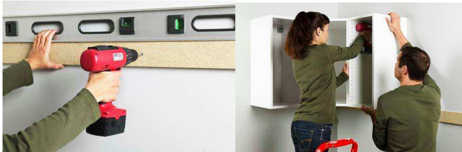
Figura 2. Utilização do calço fixo na parede.
