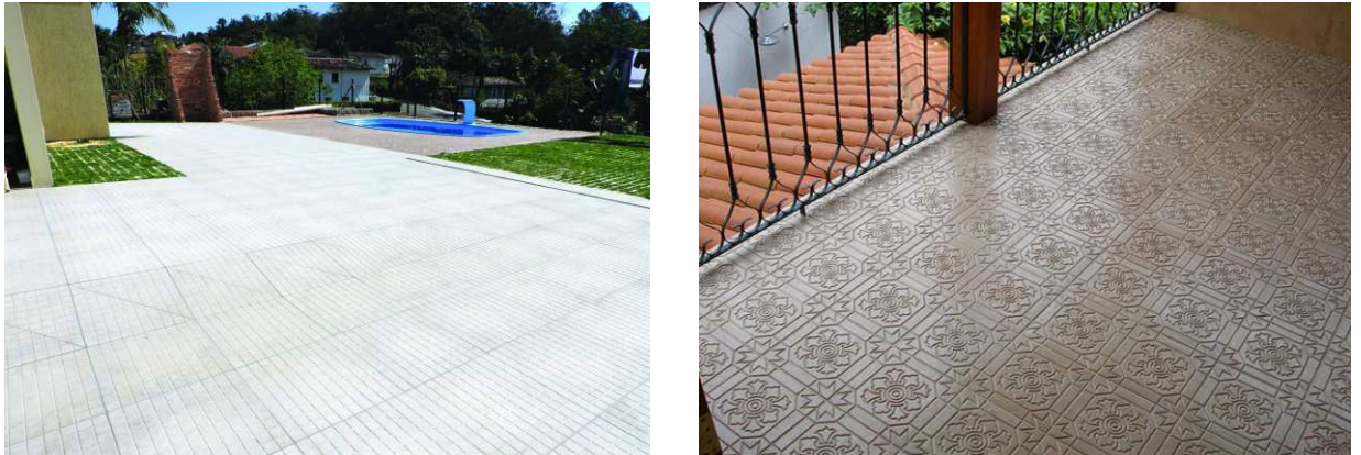
FIGURA 6: À esquerda aplicação de ladrilhos antiderrapante em área externa de ambiente privado. À direita aplicado em varanda residencial. FONTE: google.com/imagens
