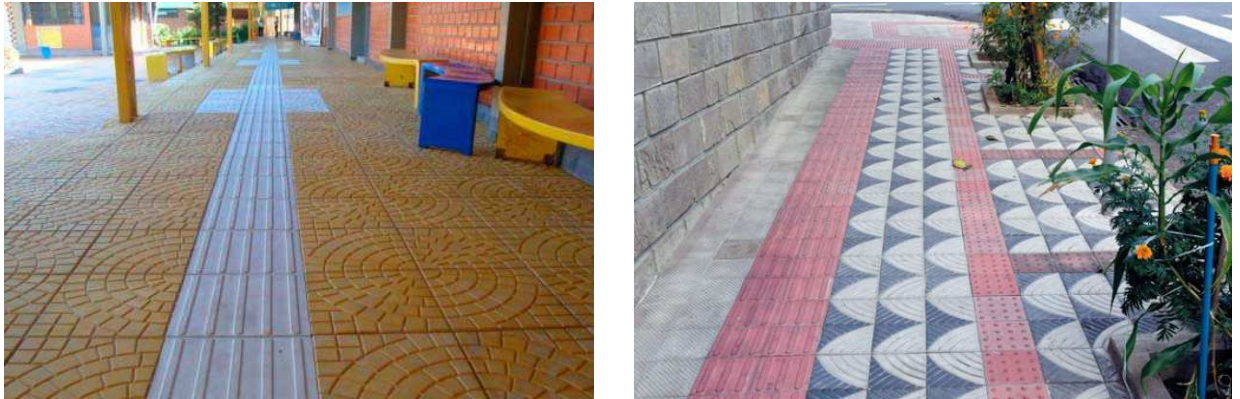
FIGURA 5: Aplicação de ladrilhos antiderrapante e tátil em áreas de passeio público. FONTE: google.com/imagens
