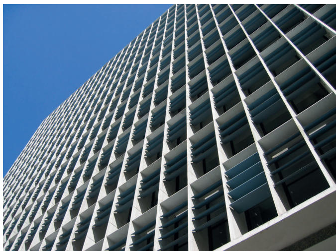
Figura 4: Edifício Gustavo Capane- ma (antigo MESP), Rio de Janeiro. Fonte: google.com/imagens
