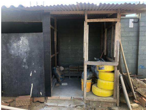
Figura 17: Almoxarifado em obra
