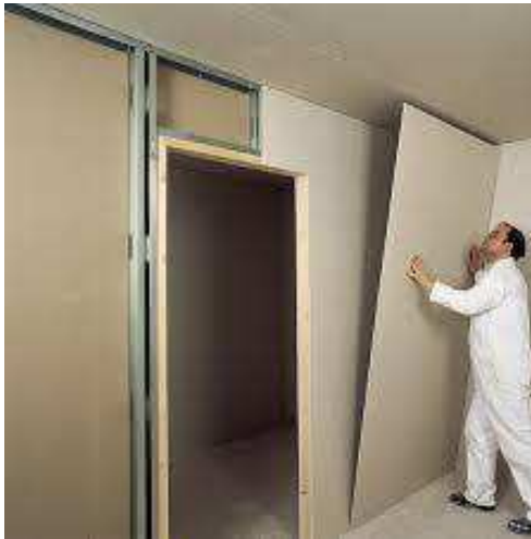
Figura 34: Fixação da chapa de drywall (Autor: Speed Dry)
