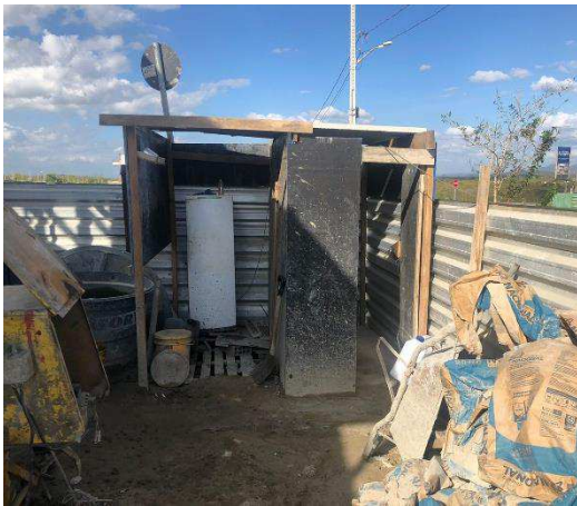
Figura 20: Banheiro temporário no meio da obra (parte 1)
