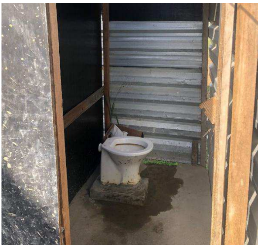
Figura 21: Banheiro temporário no meio da obra (parte 2)
