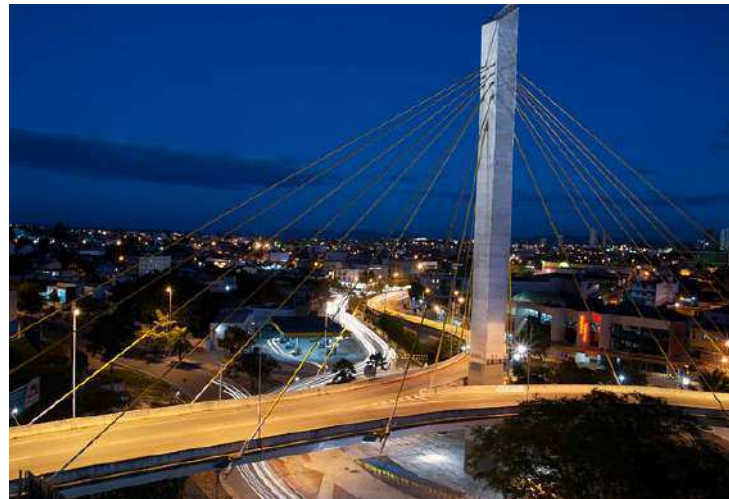
▲ Figura 9: Viaduto Elpidio de Almeida localizado no Centro da cidade Campina Grande, PB (Fotógrafo Luis Passos)
