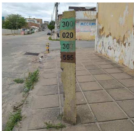
◀ Figura 18: Abrigo totem de concreto em Campina Grande, PB (autoria própria)
