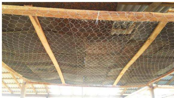
Figura 10. Base de ripas e tela de arame galvanizado para armação do forro térmico a base e E.V.A. Fonte: Acervo pessoal
