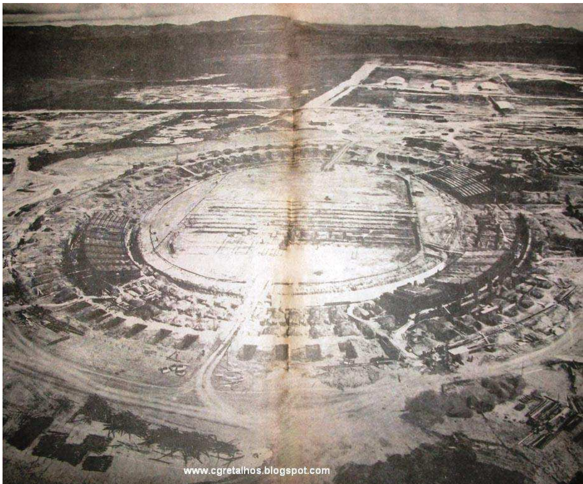
Foto 13: Estádio Ernani Satyro em construção.
