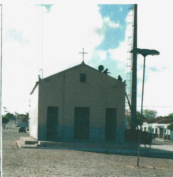
Imagem 6: Foto da Segunda Capela no início de sua demolição. Fonte: DANTAS, Lourani Celeste de Medeiros. Junho de 2003.
