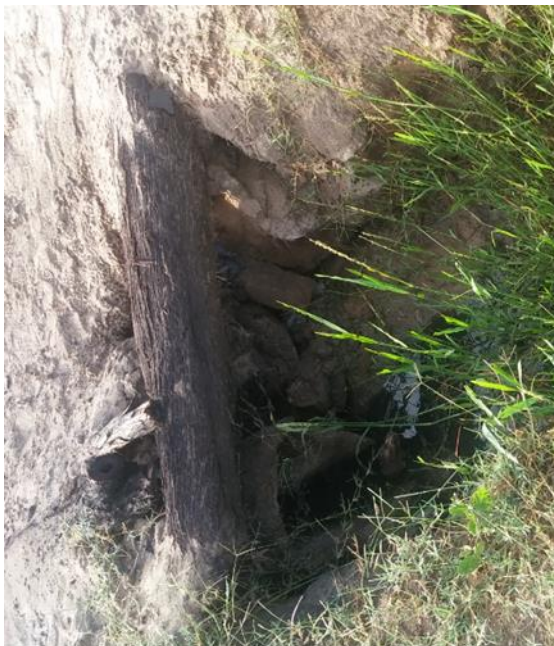
Figura 9. Lançamento de efluente.
