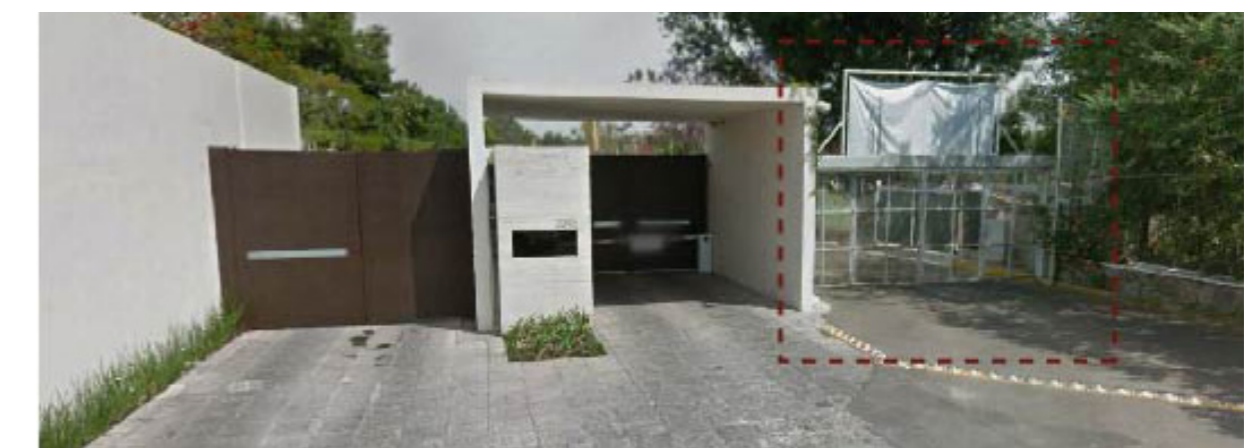
Figura 53 - Portões de acesso ao condomínio e à escola infantil
