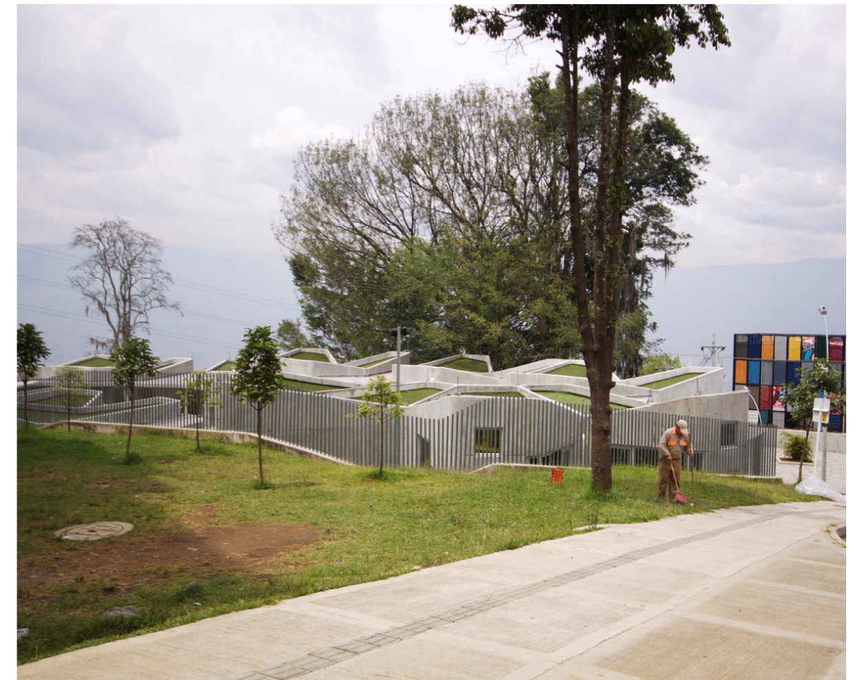
Figura 49 - Percepções fachadas oeste (acima) e sul (abaixo)
