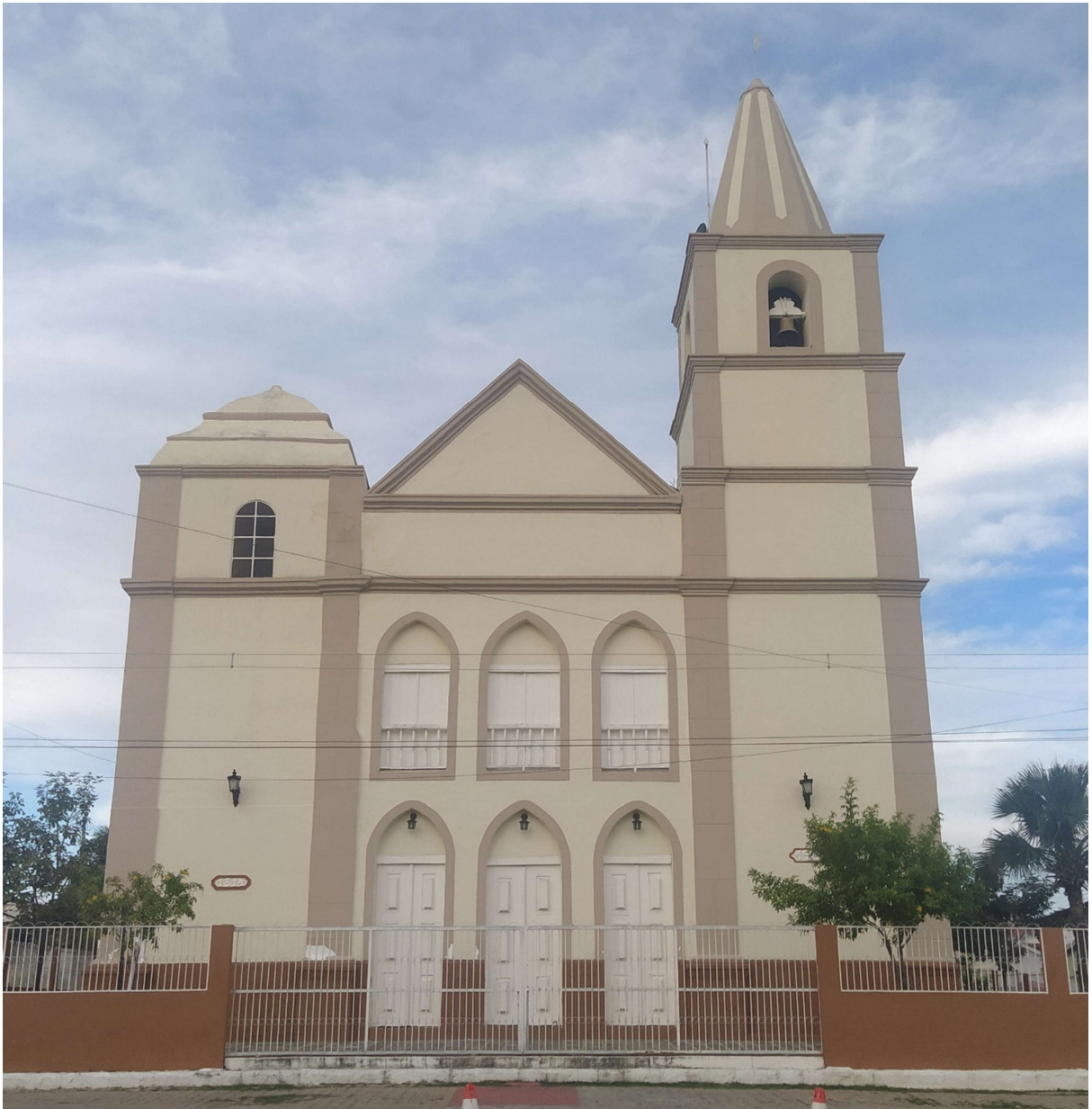
Figura 24: Imagem atual da Igreja de Nossa Senhora do Rosário.
