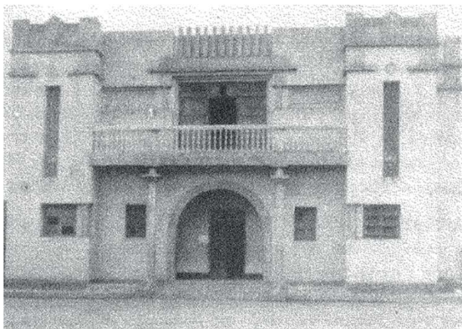
Figura 51: Imagem da Escola Normal de Ensino Santo Antônio, construído em 1947.
