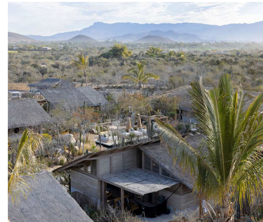
Figura 10: Vistas aérea do hotel El Perdido.
