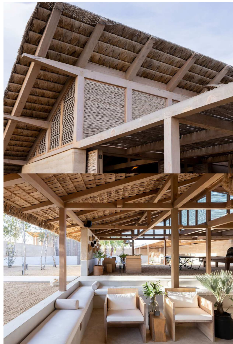
Figura 11: Imagem de parte da cobertura do hotel El Perdido.
