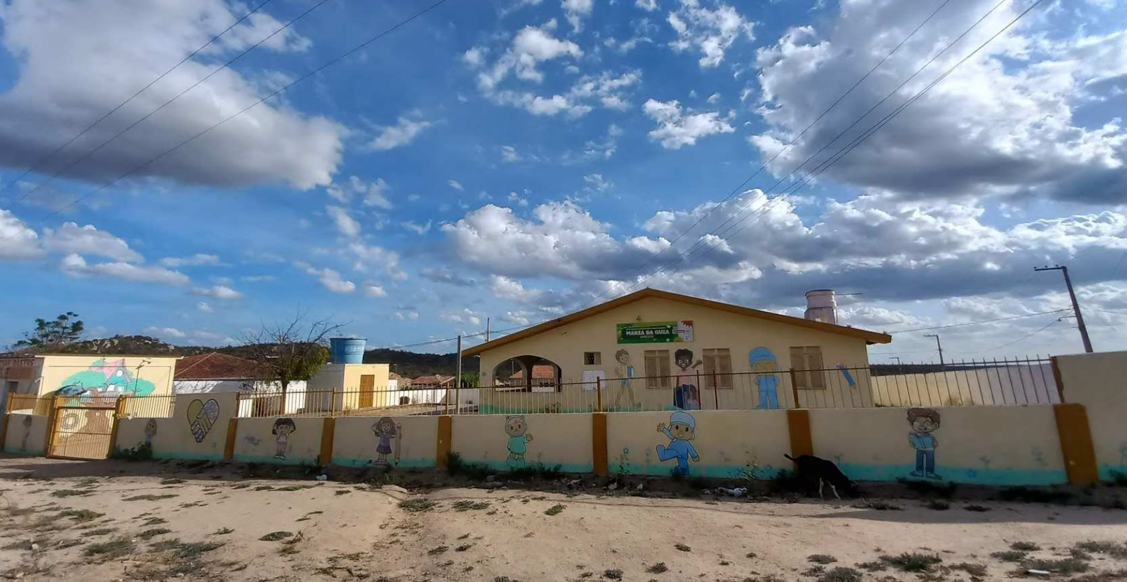
Imagem 34: Antiga sede da CONPEL, atualmente anexo da Escola Municipal Maria da Guia. Fonte: Imagem autoral, 2022.
