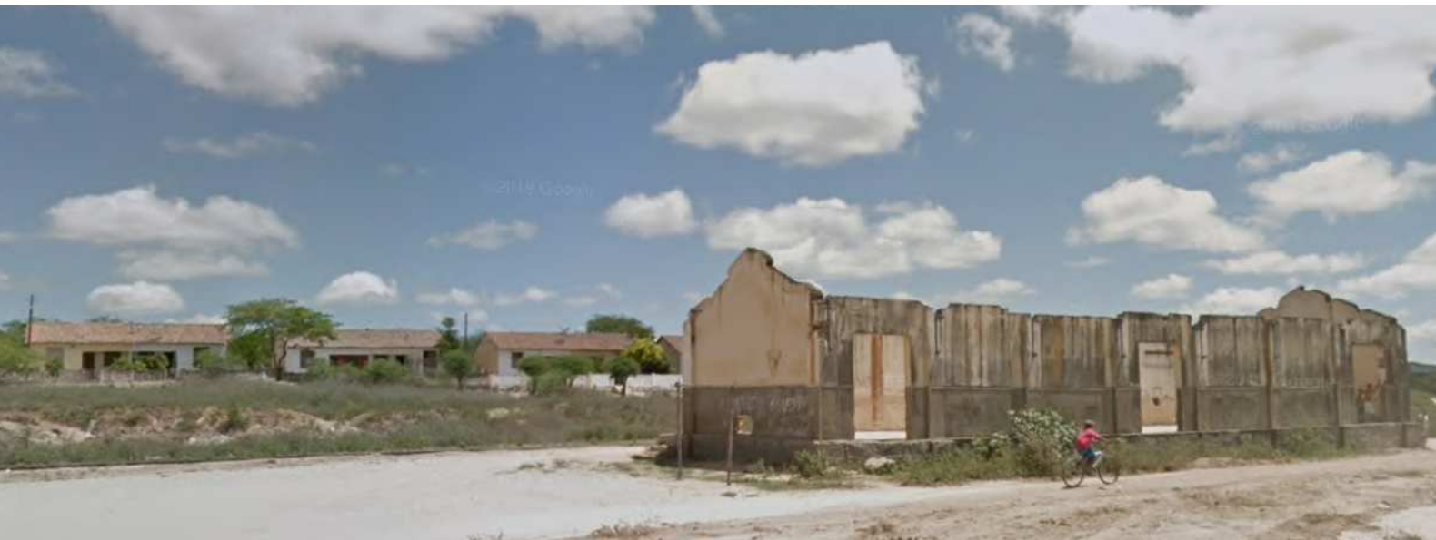
Imagem 32: habitações da vila ferroviária ao fundo, na frente estação ferroviária em ruína. Fonte: Google Street View, 2012.
