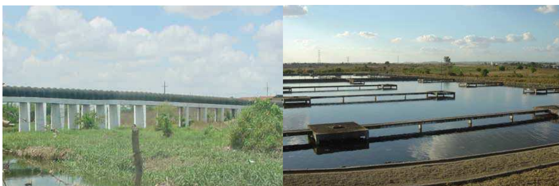
Figura 1. Emissário e lagoas de estabilização da estação de tratamento de esgotos (ETE) de Campina Grande-PB.
