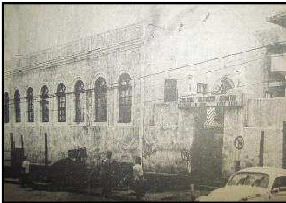
Figura 4: Fachada do Colégio Alfredo Dantas antes da Reforma
